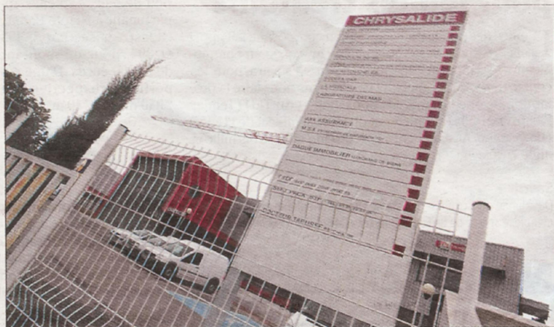
L'entreprise Techvar s'est installée aux Playes en 2007 et envisage de déménager, à moyen terme.
